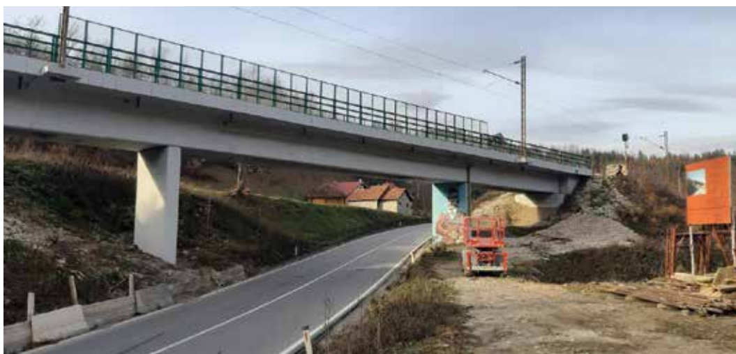
Nadzor nad radovima na sanaciji 13 betonskih mostova na pruzi Vrbnica-Bar u Crnoj Gori, ugovor po Fidic-u
