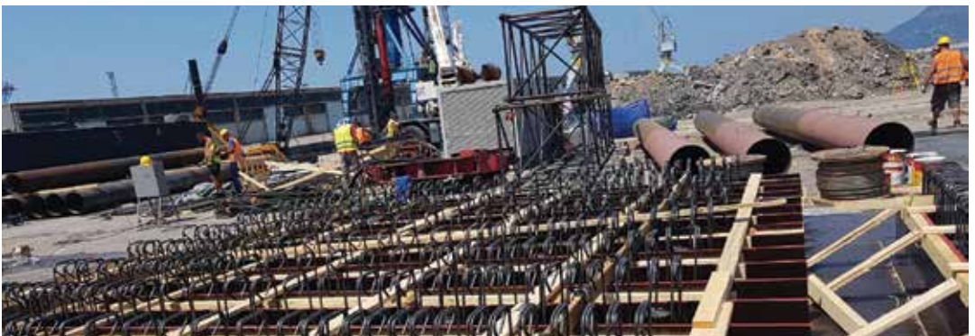
Ro Ro rampa – Glavni projekat i Nadzor radova na Ro Ro rampi na sjevernoj obali Gata 1 i luke Bar – Ro Ro linije
