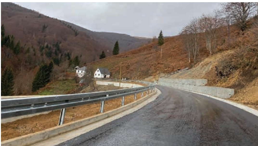
Klizište - Gnjlji potok - Nadzor na sanaciji klizišta „Gnjila Potok“ na putu Mateševo-Andrijevića od klizišta dužine 140 m u okviru kojeg je izvršena rekonstrukcija kolovozne konstrukcije
